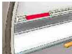
Brtvljenje vijčanih spojeva sredstvom Ködiplast CT 100
