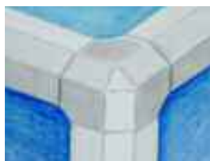
Lijepljenje rubnih profila sredstvom Körapop 225 / 2-K
