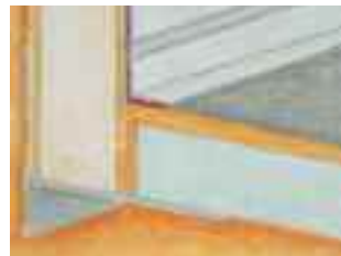
Lijepljenje podne zaštitne letve sredstvom Kōrapur 840
