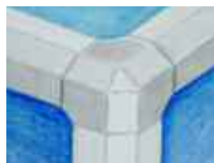
Lijepljenje rubnih profila sredstvom Körapur 140 / 2-K
